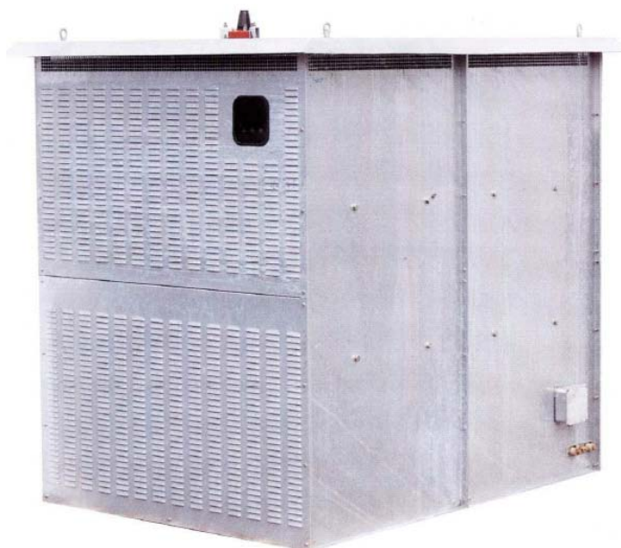
Réseau 20 kV 1000A (Agréé EDF)
